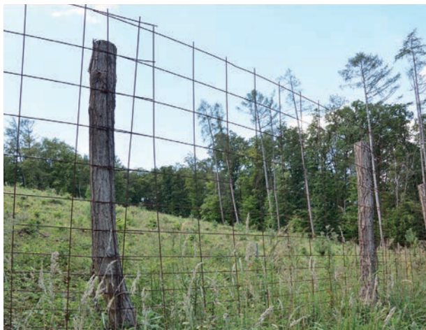
Rácsos elemekből (panel) készült vadkárelhárító kerítés ©NCs
